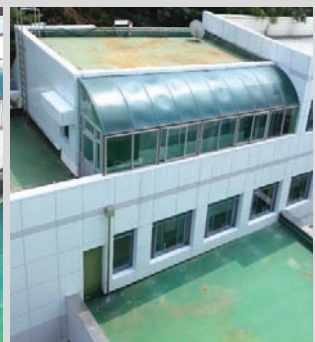
관리동 북쪽 보수 후
