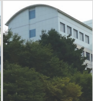
병동 북쪽 보수 후
