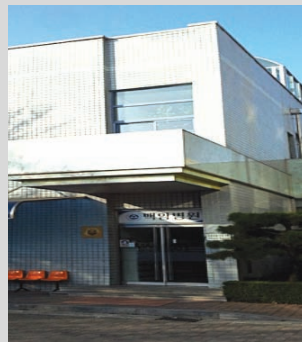
관리동 동쪽 보수 전
