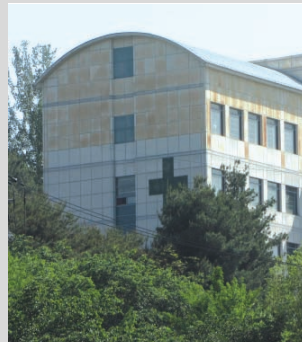
병동 북쪽 보수 전
