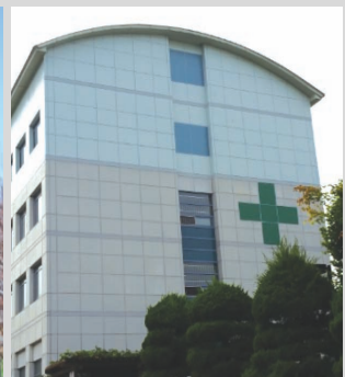
병동 동쪽 보수 후
